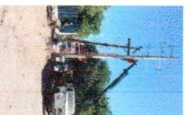
INSTALACION DE TRANSFORMADOR TIPO PEDESTAL Y TRANSICIÓN AÉREA A SUBTERRÉNEA PARA
