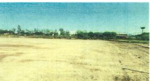
Capa de material de banco calidad sub-base que cumpla con las especificaciones de SCT, compactado con medios mecánicos al 100% de ASTM D1557
