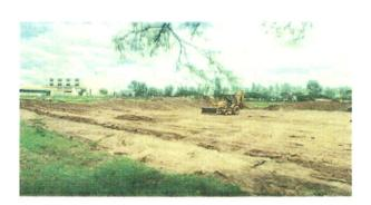
Tratamiento de terreno natural a base de escarificado de 15cms de espesor, para desplante de estructura terrea, compactado con medios mecánicos entre el 85% y 90%
